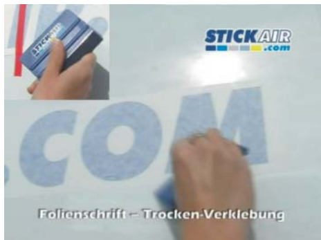
Wiederholen Sie diesen Vorgang mit der Plastikseite der Rakel
